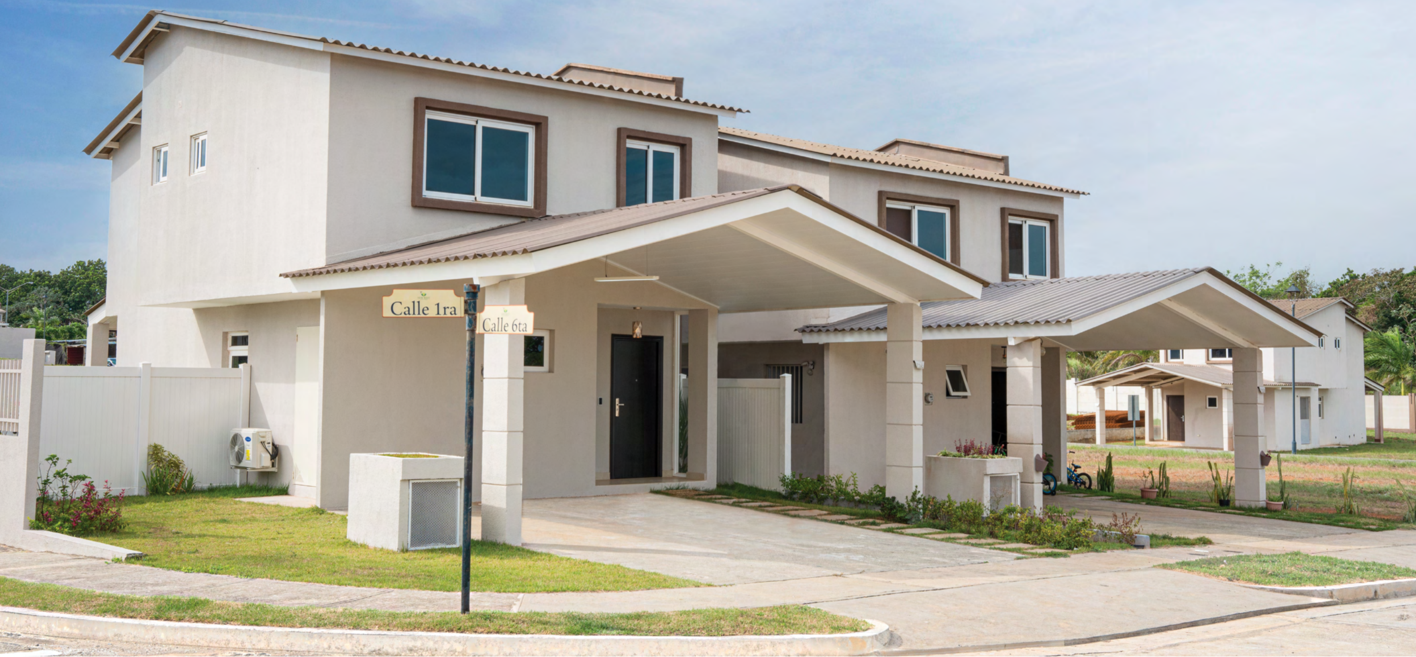
Nevada - Parte Frontal
